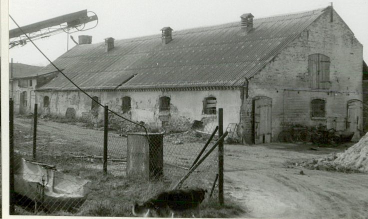
budynek chlewni w ujęciu od strony północno-wschodniej
