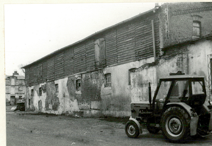
widok od strony północno-zachodniej na elewację północną
