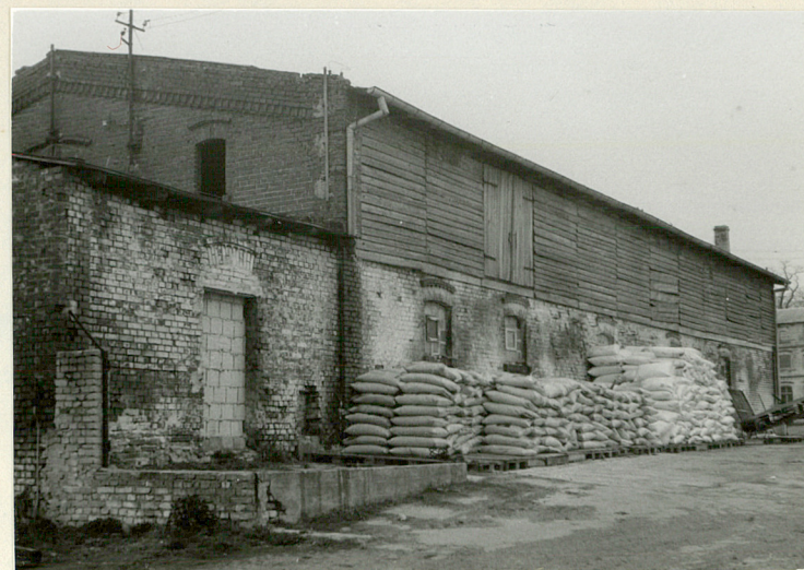
widok od strony południowo-zachodniej
