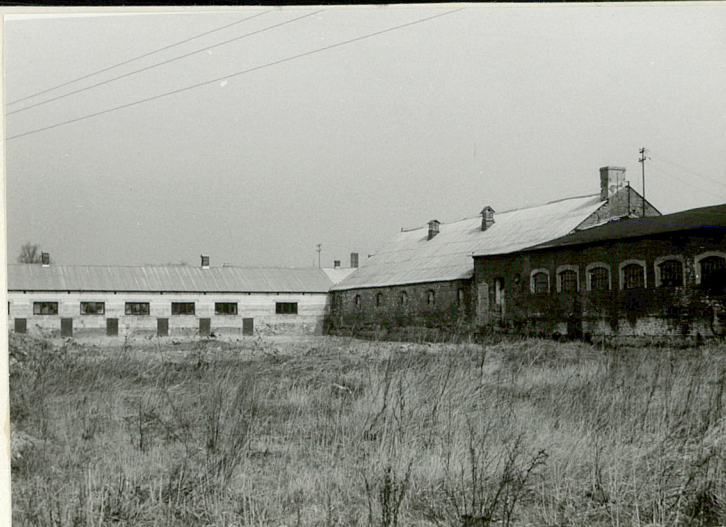
ciąg budynków, który zamyka budynek chlewni, od strony południowo-zach.
