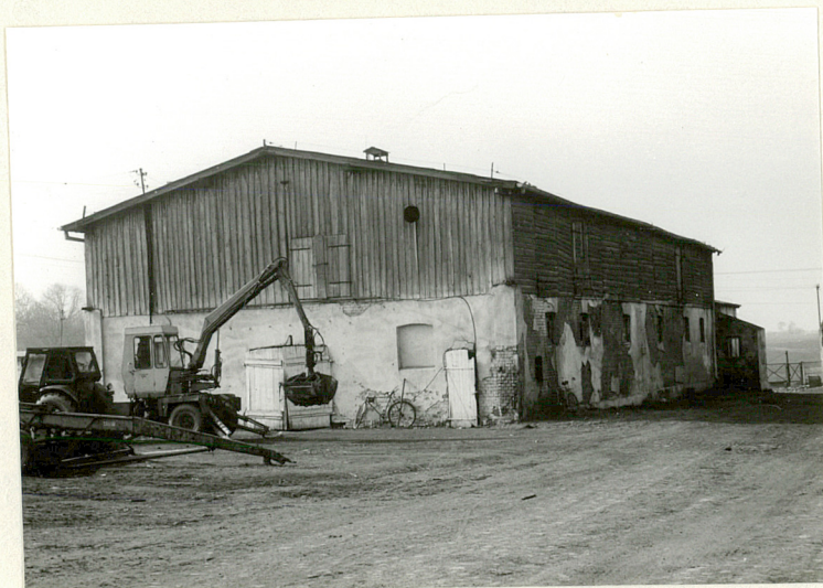
widok od strony północno-wschodniej
