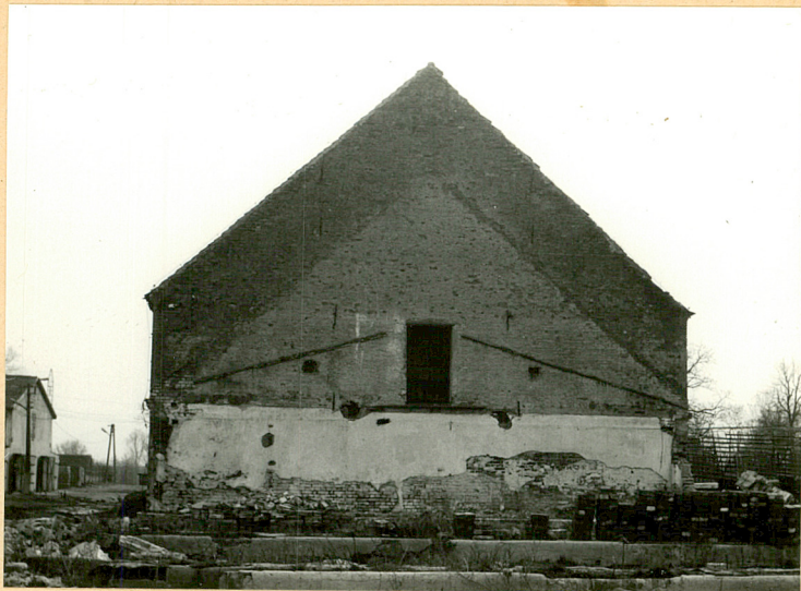
szczyt północny ze śladami dachów przylegającego budynku
