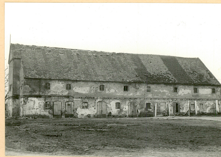
widok na elewację wschodnią
